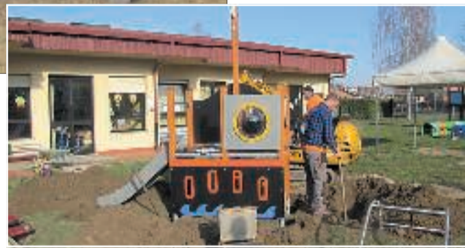
I tecnici al lavoro nella scuola d'infanzia. Sopra l'installazione dell'arredo conclusa
