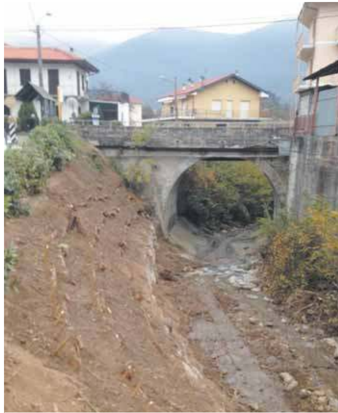
Lavori in corso nei pressi di viale Cassaz
